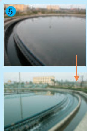
混凝沉淀池：加入混凝药物，使更细小的物质凝结沉淀
