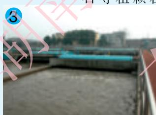
生化处理设施：用微生物分解部分有机污染物
